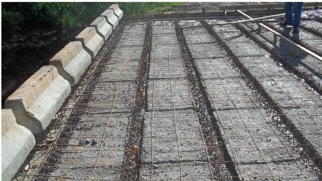
Após o processo de cura do concreto das vigas das extremidades, as armaduras da faixa de rolamento deverão ser posicionadas assim como as peças pré-moldadas do guarda rodas, guarda-corpo e/ou barreira.
