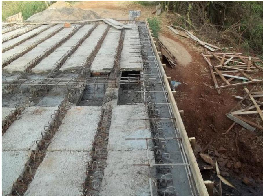
Nesta fase acontece a concretagem das vigas das extremidades até nivelar com a altura das vigas pré-moldadas. Em alguns casos também deverão ser concretadas as vigas nos apoios intermediários, conforme a foto acima.
