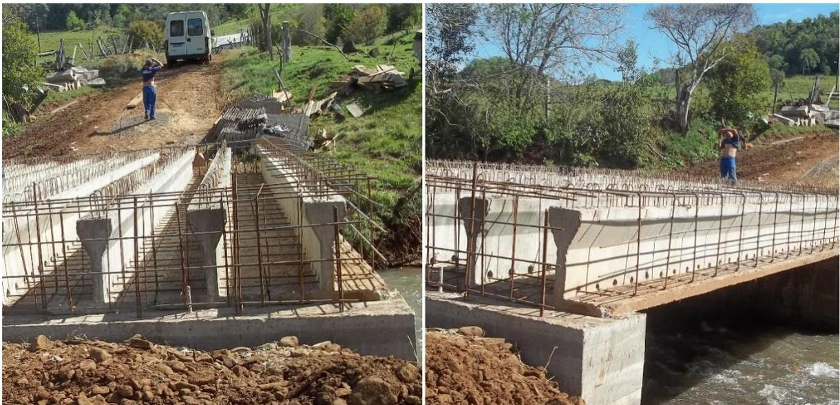
Após posicionar todas as vigas no lugar deve se proceder com a montagem da armadura conforme a Prancha 10 Projeto de montagem de viga. As armaduras das vigas das extremidades merecem atenção redobrada.
