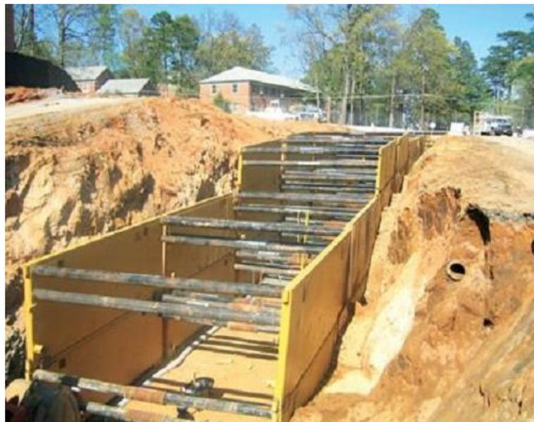
Figura 2 – Estroncas Horizontais
