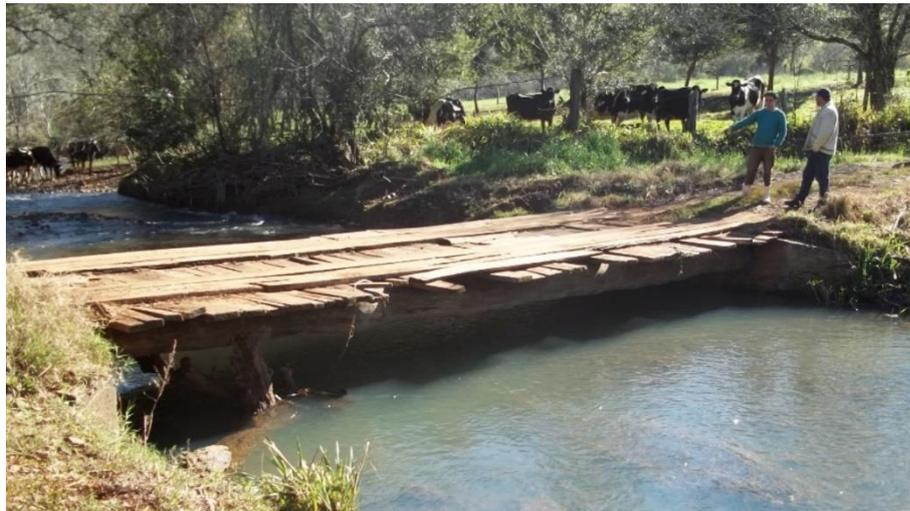
Inicialmente existia uma ponte de madeira no local, porém com o aumento do tráfego somado ao fato da cota da ponte deixar pouca folga para a variação do nível rio foi decidido implantar uma ponte de concreto em um nível mais alto. Para o cálculo da cota ideal da ponte é necessário realizar o Estudo Hidrológico do rio em questão.
