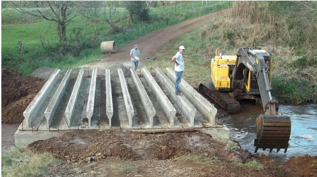
As vigas deverão ficar com pelo menos 25cm do seu comprimento apoiadas em cada cabeceira e não poderá haver espaçamento entre elas visto que haverá uma camada de concreto sobre as abas das mesas das vigas.
