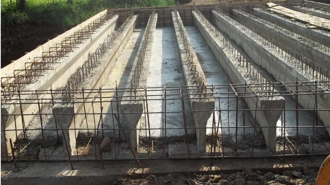
Nesta fase deverá ser lançado 5cm de concreto na base das vigas de modo a cobrir os aços N3 e N6.
