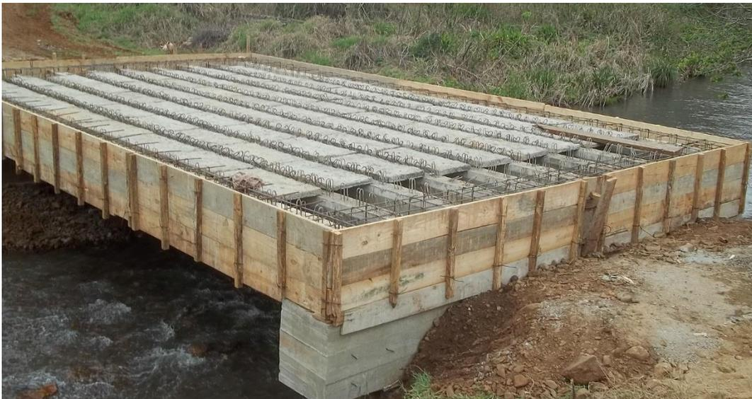
Após o processo de cura do concreto da base das vigas poderá ser realizado o posicionamento das placas de concreto pré-moldadas e das fôrmas das vigas das extremidades.
