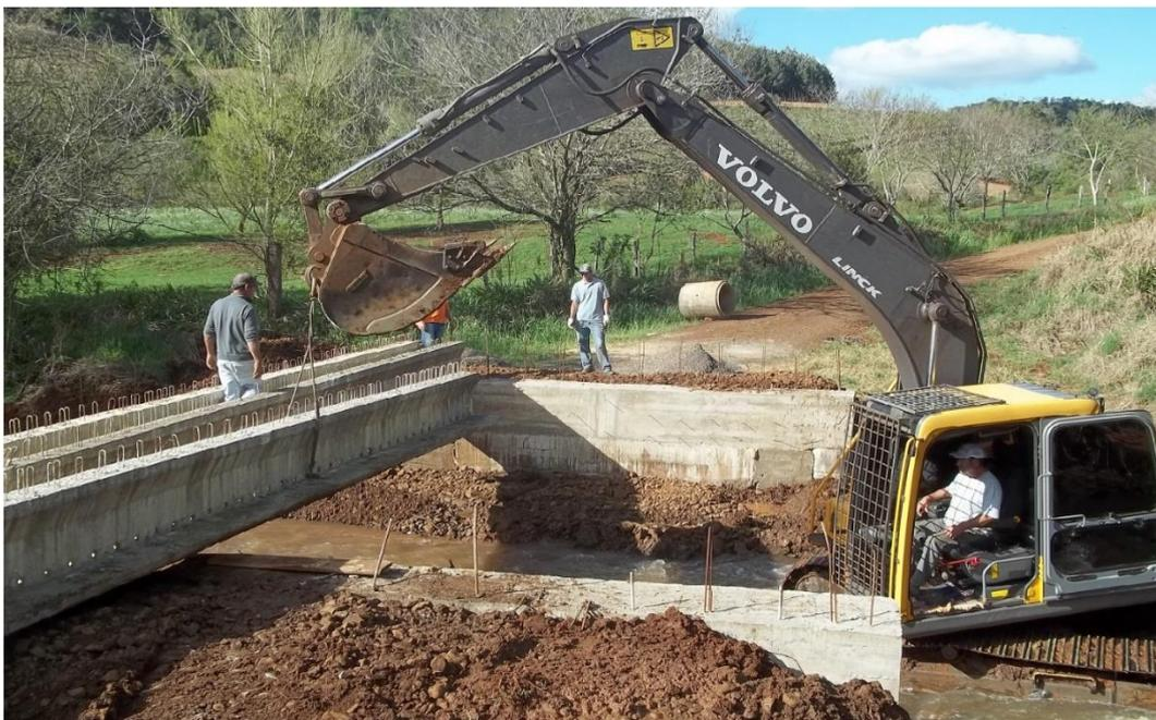
Após a finalização do processo de cura do concreto da viga da cabeceira deverá ser realizado o lançamento das vigas pré-moldadas. O lançamento é realizado com guindaste, caminhão munck ou com equipamento compatível com a carga das vigas.
