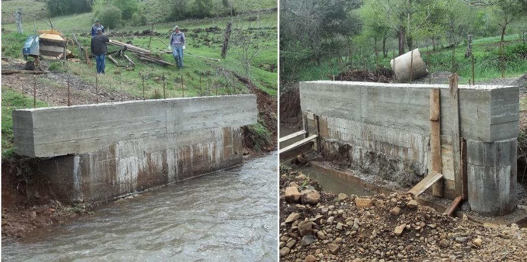
Neste caso os apoios existentes eram de concreto, porém havia a necessidade de elevar a cota da ponte. Foi decidido por executar a viga travesseiro conforme a Prancha 9 Viga travesseiro com aproveitamento do muro.
