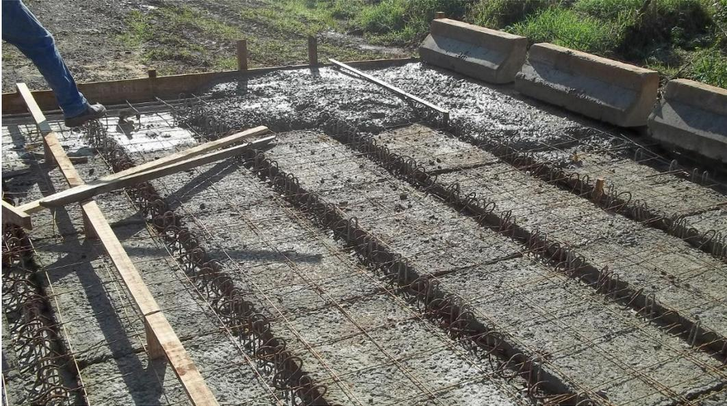
Com as peças posicionadas poderá se iniciar a concretagem final do tabuleiro da ponte.
