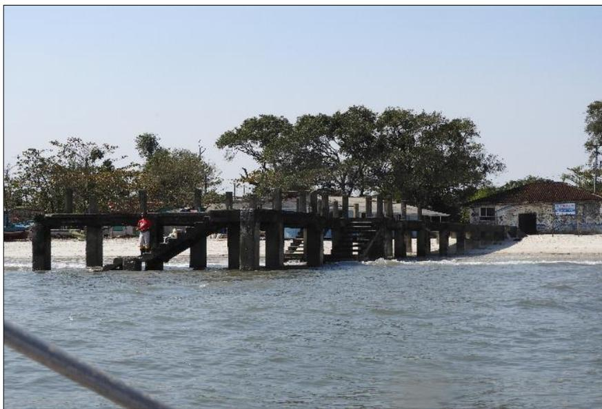
**Figura 48 – Terminal da Vila de Superagui em situação de maré cheia. Em meio a ventos e ondas com direção transversal à linha de praia, há risco de colisão de embarcações com a estrutura de concreto**
