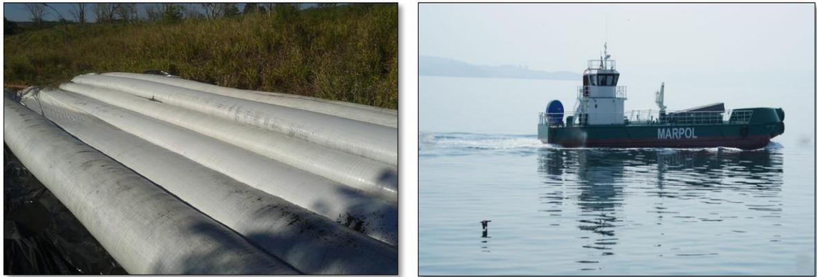
Figura 38 – Contentores geotêxteis de pequeno diâmetro (dir.) e embarcação autopropelida de transporte de resíduos sólidos urbanos (esq.)
