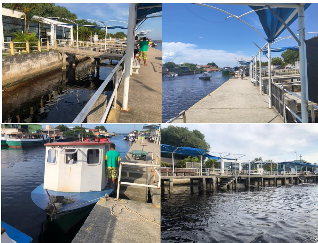
Figura 27 – Píer de acesso aos Barcos Regulares
