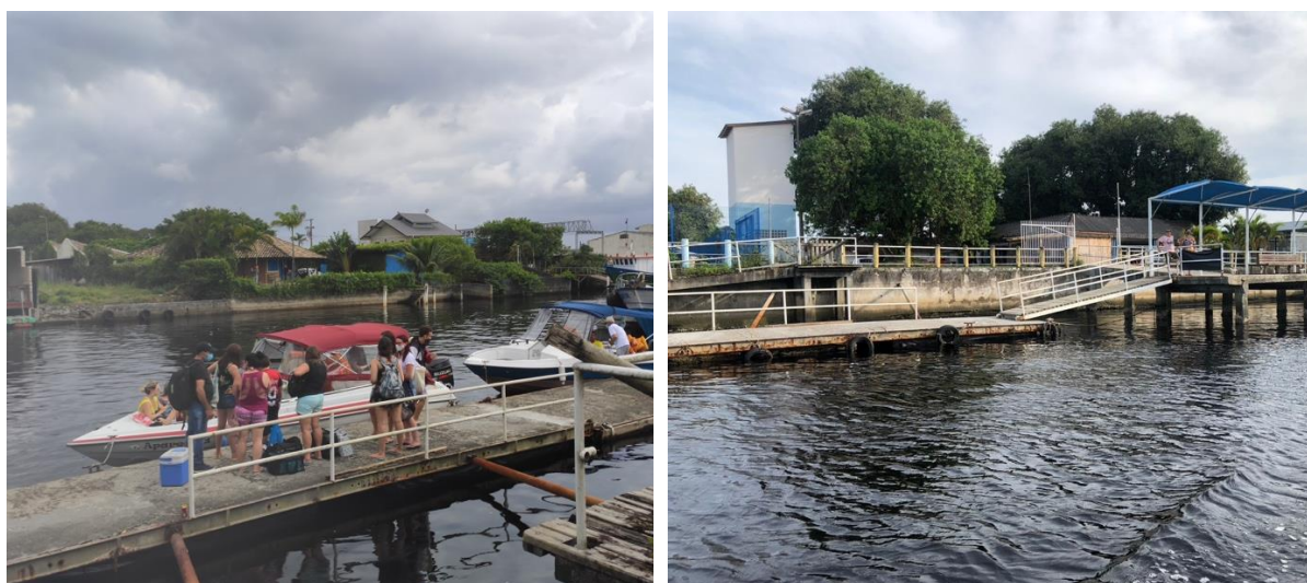
Figura 28 – Píer flutuante das Lanchas
