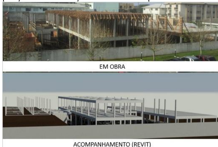
Figura 8. Comparação entre a execução da obra e o acompanhamento do modelo paramétrico
