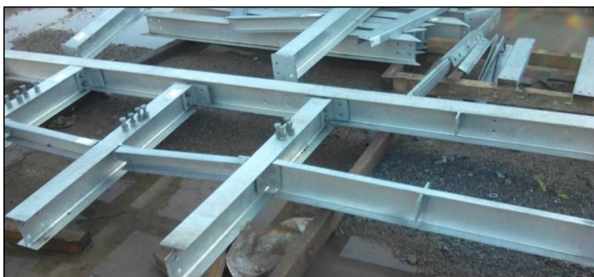
Figura 10 – Início da pré-montagem de uma elevação
