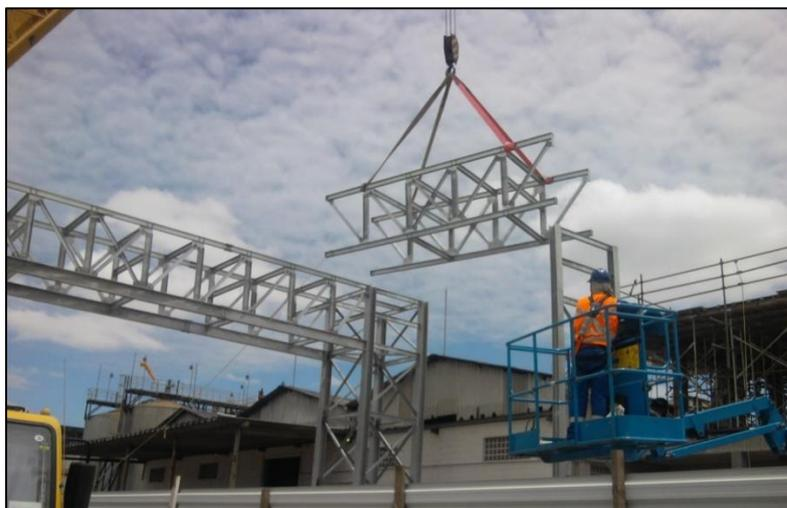
Figura 11 – Içamento de um módulo de *pipe-rack* pré-montado em solo
